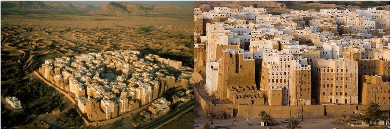
La tecnica più diffusa per ottenere pannelli murari a comportamento monolitico è quella del **pisè** (noto anche come *Tapia* o *Rammed Earth*): la terra, inclusi i granuli più grossi che fungono da inerti, è impastata con la sua umidità naturale e versata all'interno di casseri. Dopo aver versato circa 1,20 m di terra si comprime, tradizionalmente con dei pestelli di varia forma, oggi giorno meccanicamente, ottenendo, in tal modo, un notevole incremento della resistenza del materiale.
