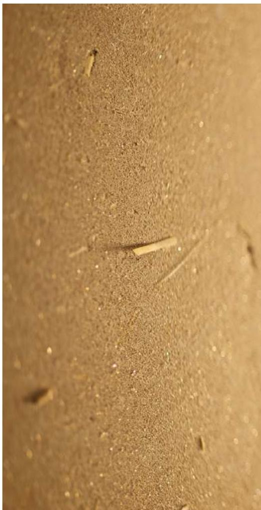
Le pareti perimetrali sono composte, dall'interno verso l'esterno, da un paramento di blocchi pesanti in TerraViva (un composito di terra cruda vergine e fibre vegetali, la cui massa specifica è di 1688 Kg/mc), costituito da una singola fila di elementi di vario spessore e dalla coibentazione in canapa - canapulo - sughero inserita nello spessore della struttura portante, questi ultimi dimensionati per raggiungere un determinato Valore U.
