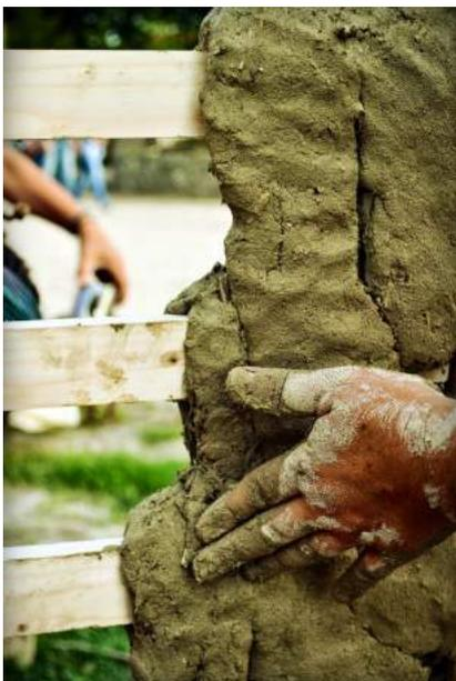
La parte più laboriosa della tecnica del torchis consiste nella predisposizione del grigliato sul quale deve essere posato l'impasto a mano. Per questo motivo, in alcuni paesi, si è pensato di realizzare dei pannelli prefabbricati da applicare direttamente alla struttura a telaio.
