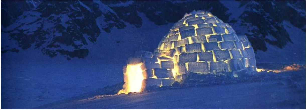
I concetti che stanno alla base del funzionamento dell'Igloo di neve sono tanto semplici quanto efficaci: orientamento del tunnel di ingresso sottovento, forma aerodinamica, impermeabilità all'aria e all'acqua, isolamento termico dovuto all'aria contenuta nella neve.
